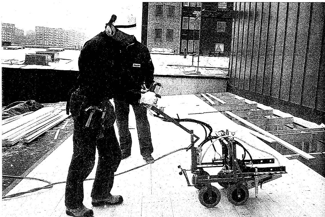
Spikning av råspont på en arbetsplats i Göteborg
